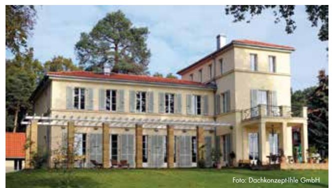
Foto: Dachkonzept-Ihle GmbH
